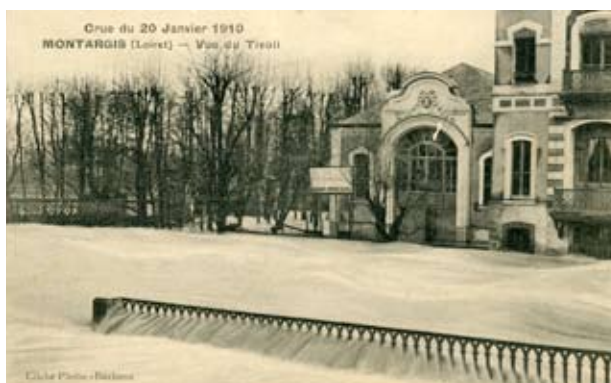
Source : Fonds des Amis du Vieux Montargis (3Z) Archives municipales de Montargis
