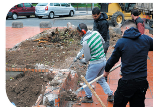
Chantier d'insertion association OIE
