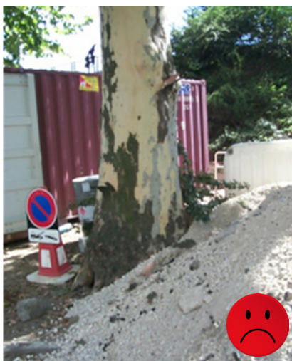
Photos 9 et 10 : Dégâts suite au stockage de matériaux en pied d'arbres.
