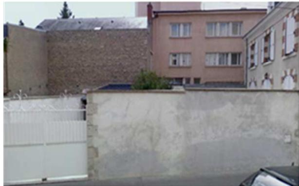
De toute évidence un mur remplaçant un mur ancien rénové (ou en réparation) dégradant la qualité urbaine. Le portail décoré garde une certaine grâce totalement contredite par la banalité de la maçonnerie. Un soubassement aurait permis d'alléger cette masse maçonnée supérieure à 2 m.
