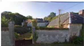
Patrimoine remarquable – rue de Grenouilly
