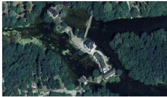
Chaussée de Saint-Santin (orthophoto 2006 © CG45)
