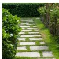
Pavés à joints enherbés
