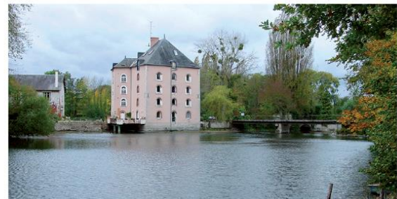
Le moulin Brûlé et la passerelle (à droite) reliant la chaussée à la rue de Saint-Santin.
