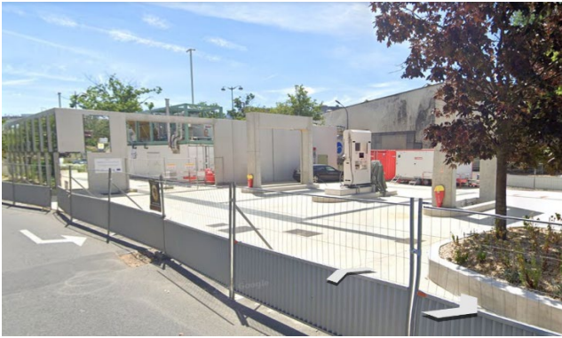
Chantier d'installation d'une station à Paris 16 ème
