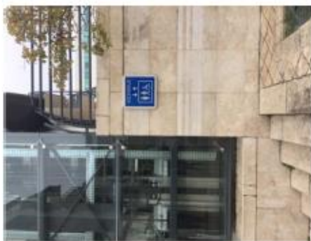
Jalonnement ascenseur Place Coligny
