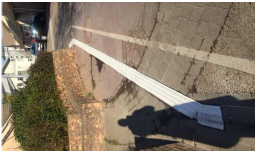
Pose bande de guidage rue Degas
