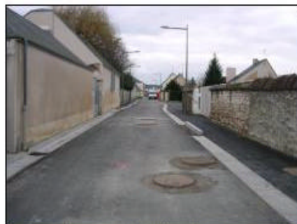
Travaux en cours de la rue Chardon
